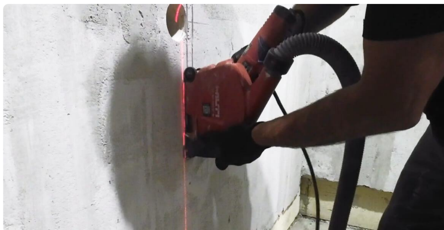
Рис. 1. Штробление стены
