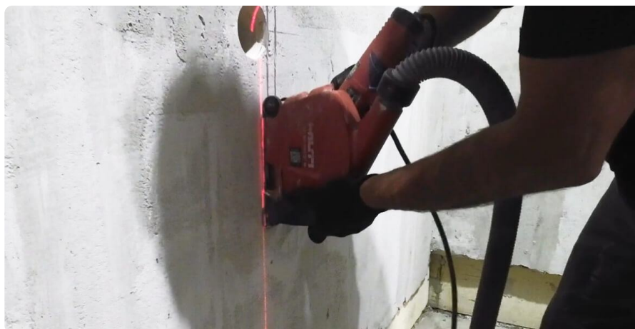
Рис. 1. Штробление стены
